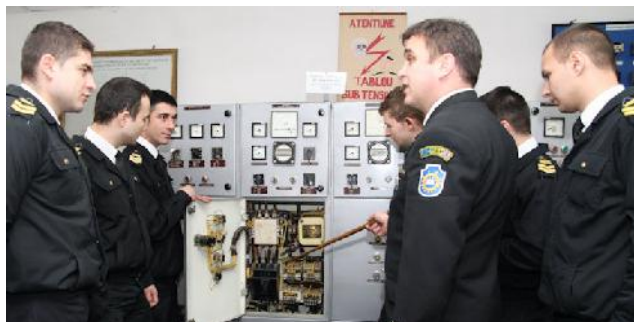
Cabinet mașini și instalații electrice
